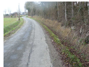
Curage des fossés
