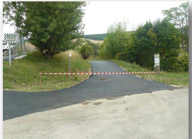
Chemin d'accès de la STEP
