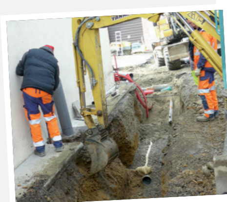
Travaux assainissement collectif au village
