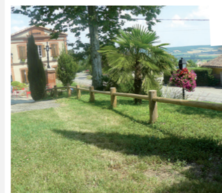
Pose de poteaux et lisses espace du 19 mars
